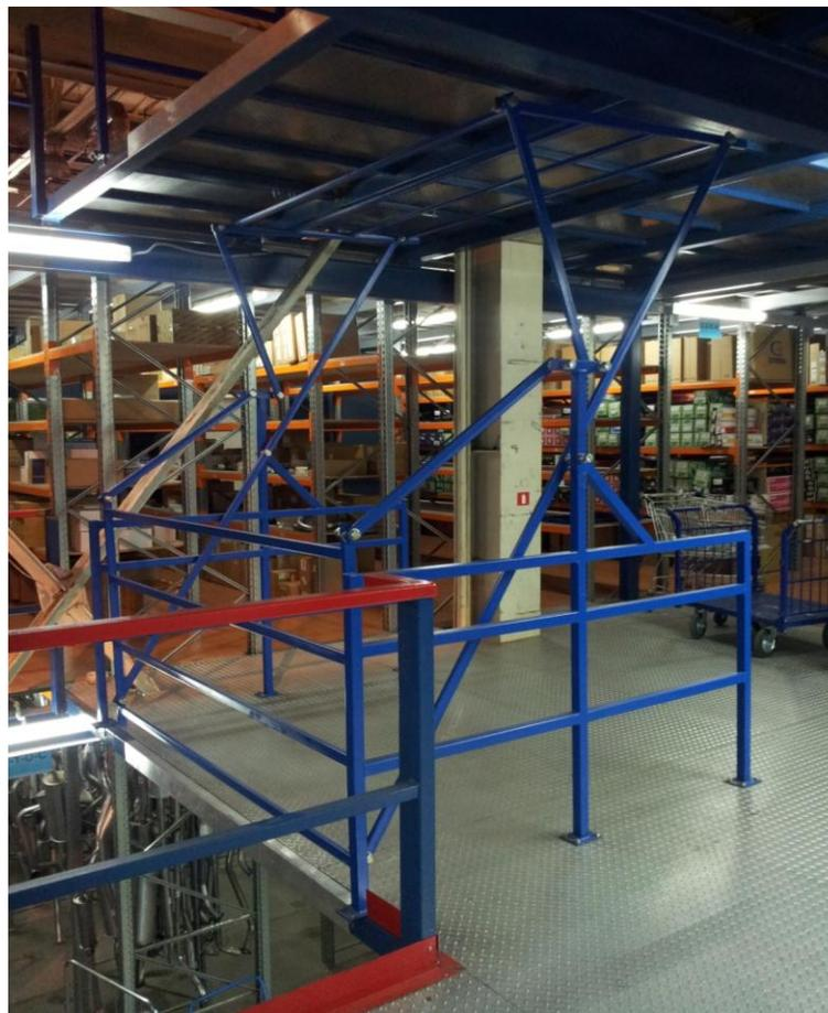
Производится из круглой или квадратной трубы. Высота ограждающей конструкции – согласно технического задания.
