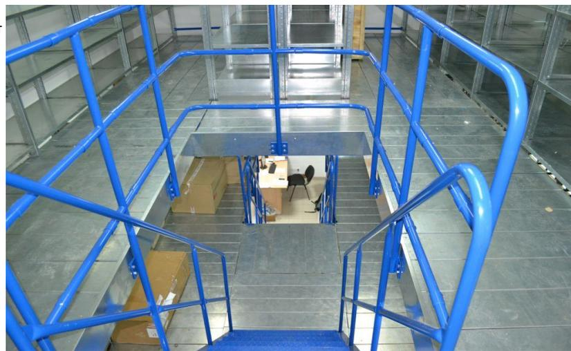
Производится из стали оцинкованной толщиной 1,5 - 2 мм. Длина половицы до 2500 мм.
