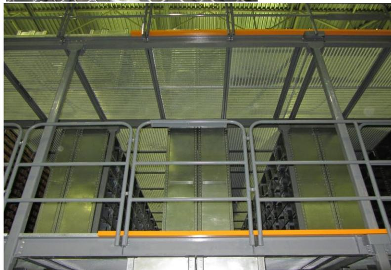
Производится из круглой или квадратной трубы. Высота ограждающей конструкции – согласно технического задания.
